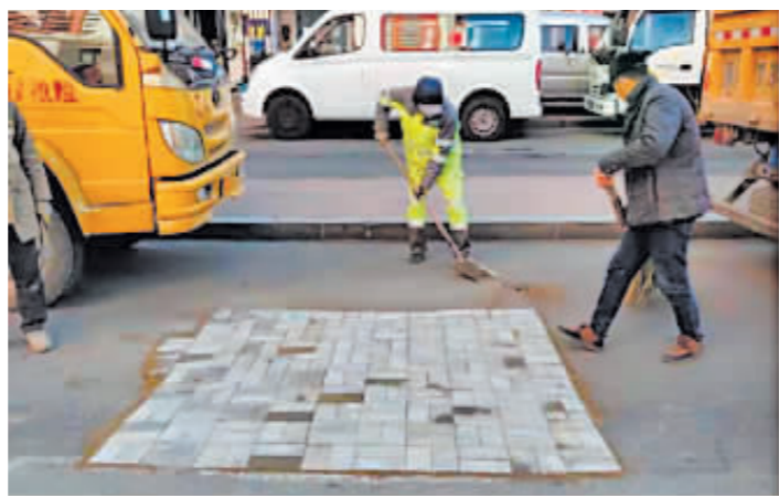
维修后的路面。
