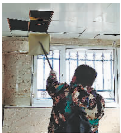
工作人员拆除楼顶违建。
