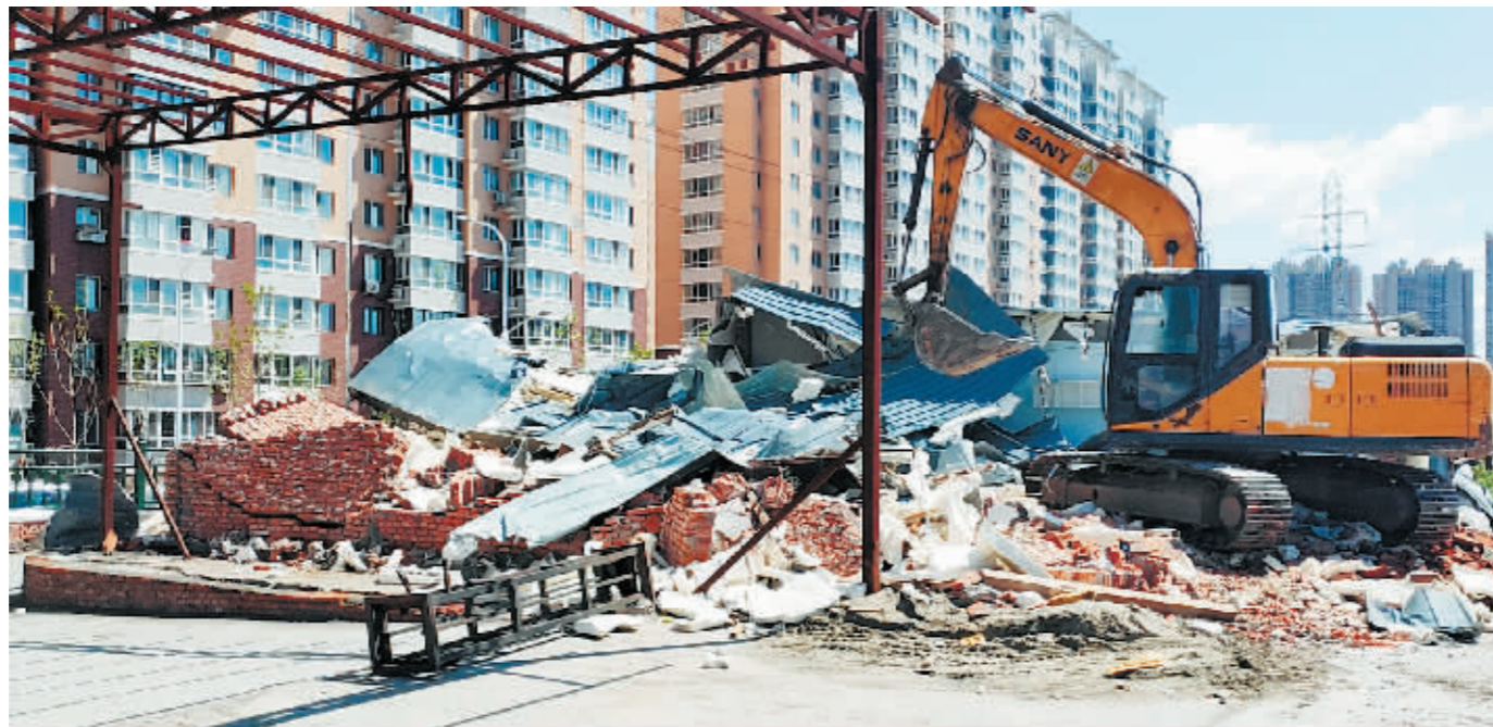
文景街一座大型违建仓库被拆除。
