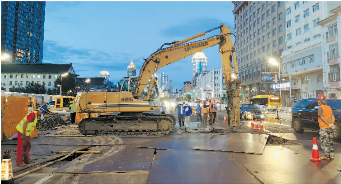
钻机推开路面加盖的钢板,开始晚间施工。
