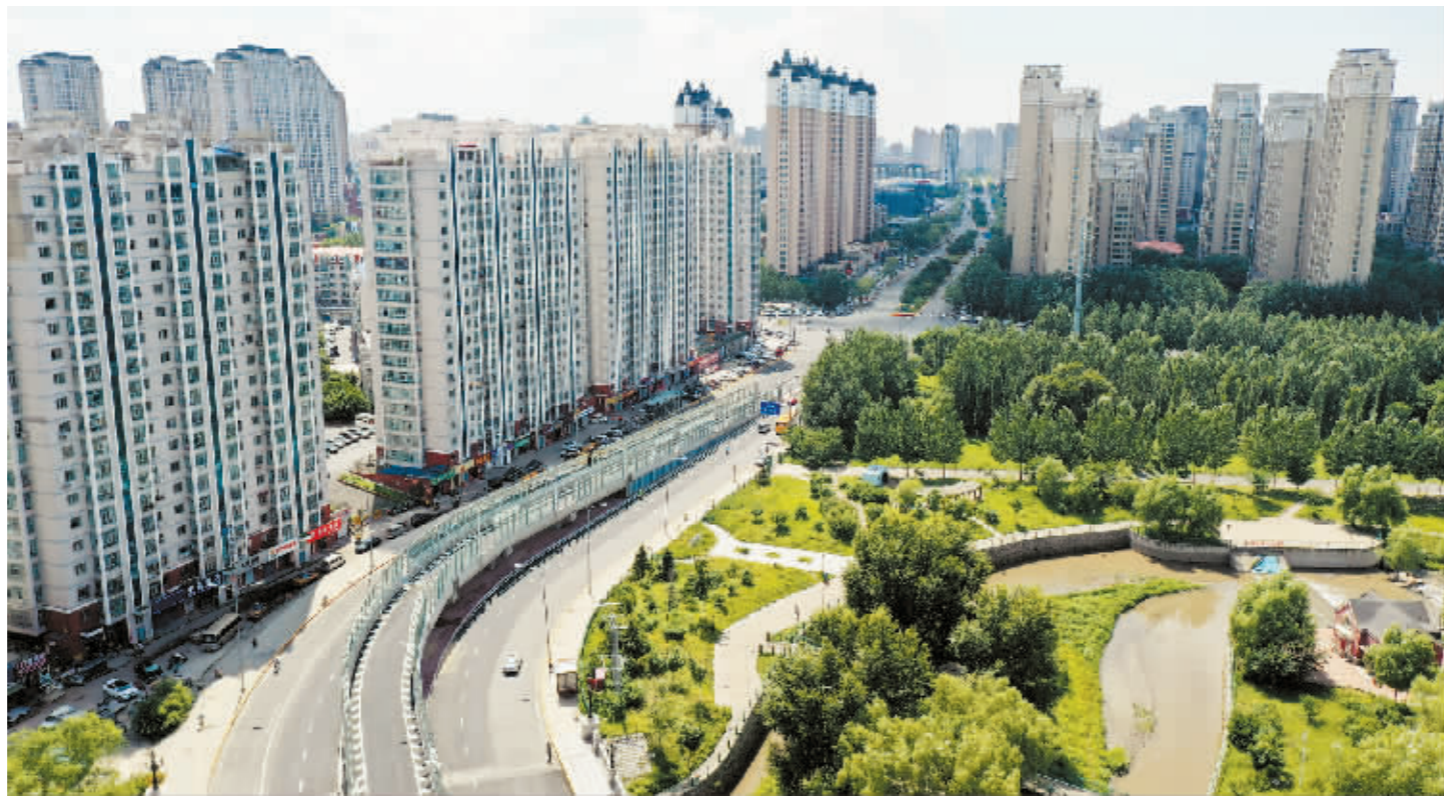
新建成的安阳路支线桥上江街下桥匝桥。
