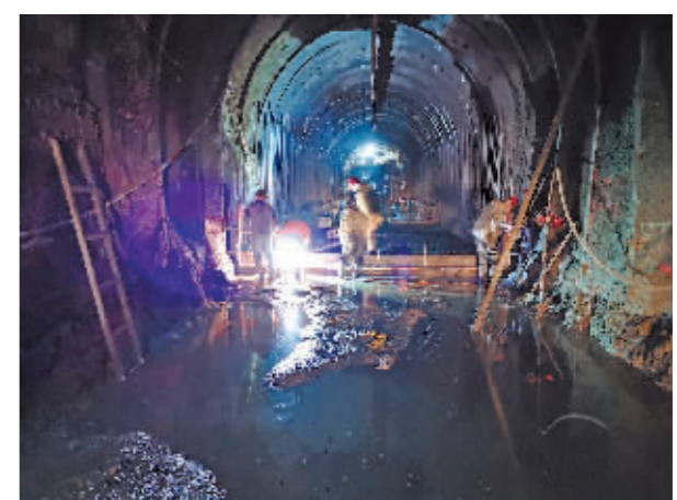
二甲沟水库内部建设现场。
