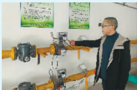
铁路东棵小区工作人员在调试锅炉房燃气设备。
