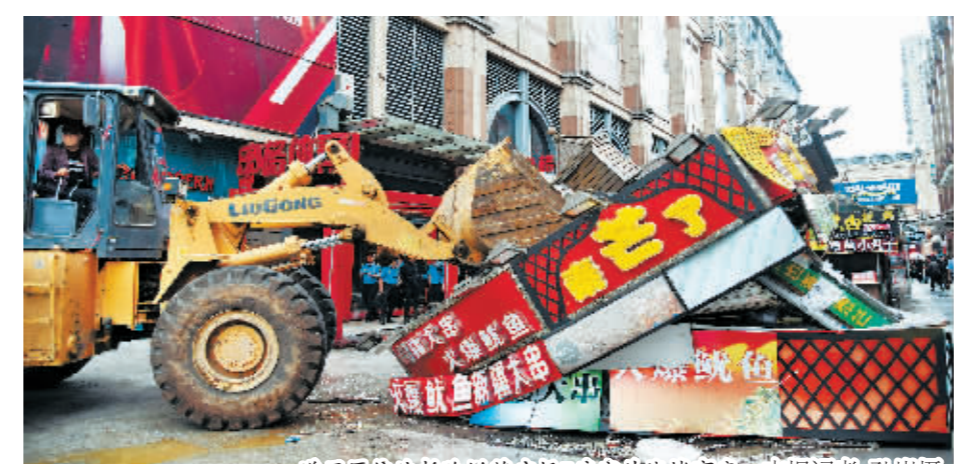
道里区依法拆除悦荟广场7座室外烧烤商亭。本报记者 孙岩摄
